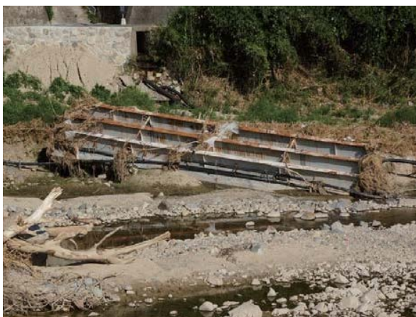
図4：[参考] 同水系の同じ鋼桁橋梁タイプの安駄橋の崩壊事象
